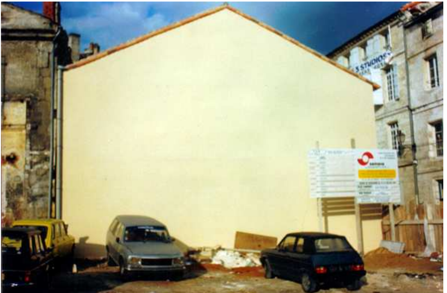
Fin des travaux, la salle principale est terminée.
